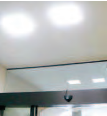
Landratsamt in der Haußmannstraße: Sanierung der Innenbeleuchtung
