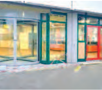
Kreisberufsschulzentrum Ellwangen: Neue Karusselltüre im Hauptgebäude
