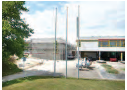
Berufliches Schulzentrum Schwäbisch Gmünd: Erweiterungsbau Theorieräume
