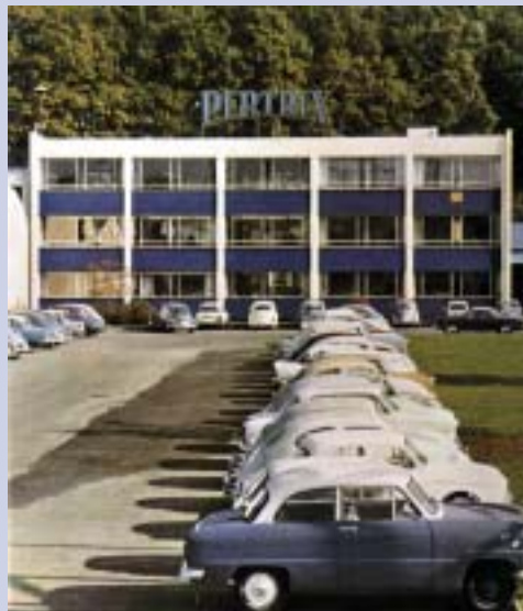
Verwaltungsgebäude Ellwangen der Pertrix-Union GmbH
