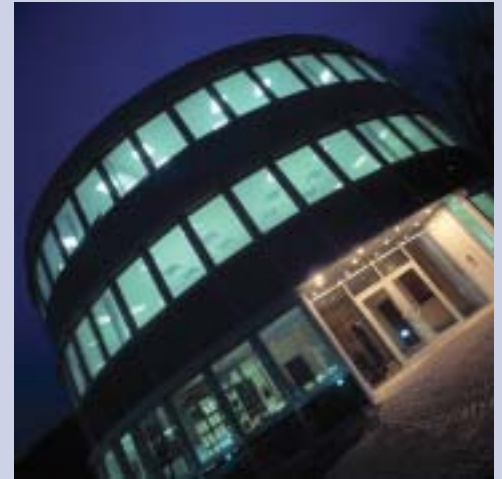
„Rundbau“ - Vertrieb Inland und Handel
