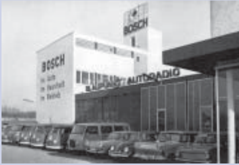
Neubau der Firma Lipp, Aalen
